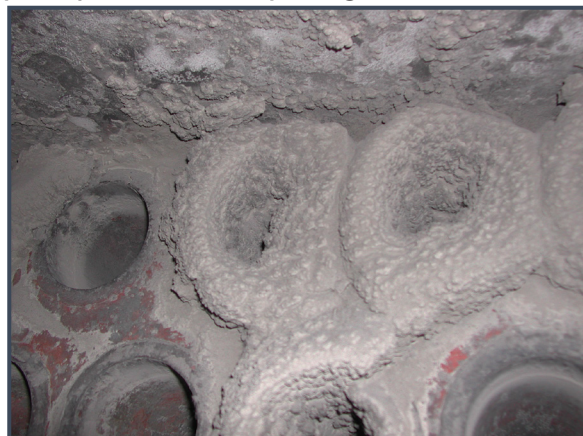
Nagromadzenie sadzy w kotle na biomasę
